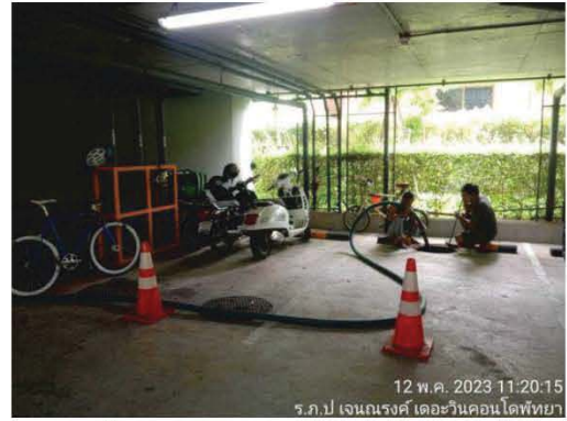
เจ้าหน้าที่ดำเนินการสูบลบระบบบำบัดน้ำเสีย (12/05/66)
