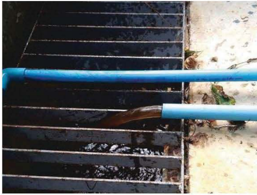
ดำเนินการล้างไส้กรองน้ำเครื่องกรองน้ำ
