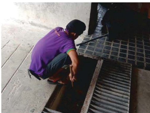
เจ้าหน้าที่ดำเนินการทำความสะอาดรางระบายน้ำ
