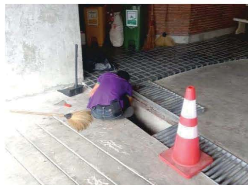
เจ้าหน้าที่ดำเนินการทำความสะอาดรางระบายน้ำ
